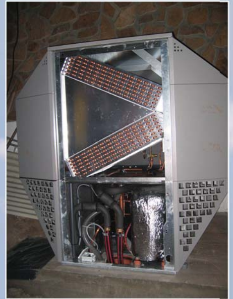
A berendezés lelke a hőcserélő, amit német, svájci kutatók, fejlesztők dolgoztak ki.
