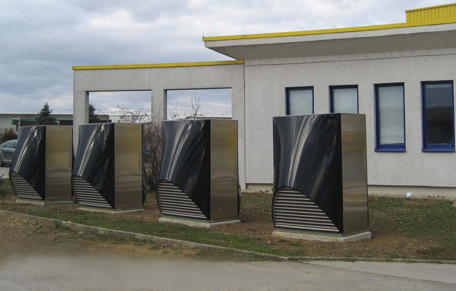
A képen látható kültéri levegőkazán blokk egy közel 2000 m 2 -es iroda, raktár blokkot fűt és lát el meleg vízzel.
