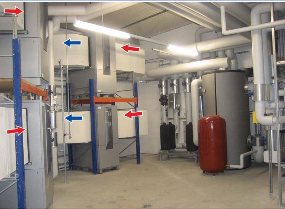
A képen jól látni, hogy a beltéri levegőkazánok egymásra vannak helyezve. A külső levegőt két szélen szívják be, az elhasznált levegőt középen fújják ki a szabadba.
